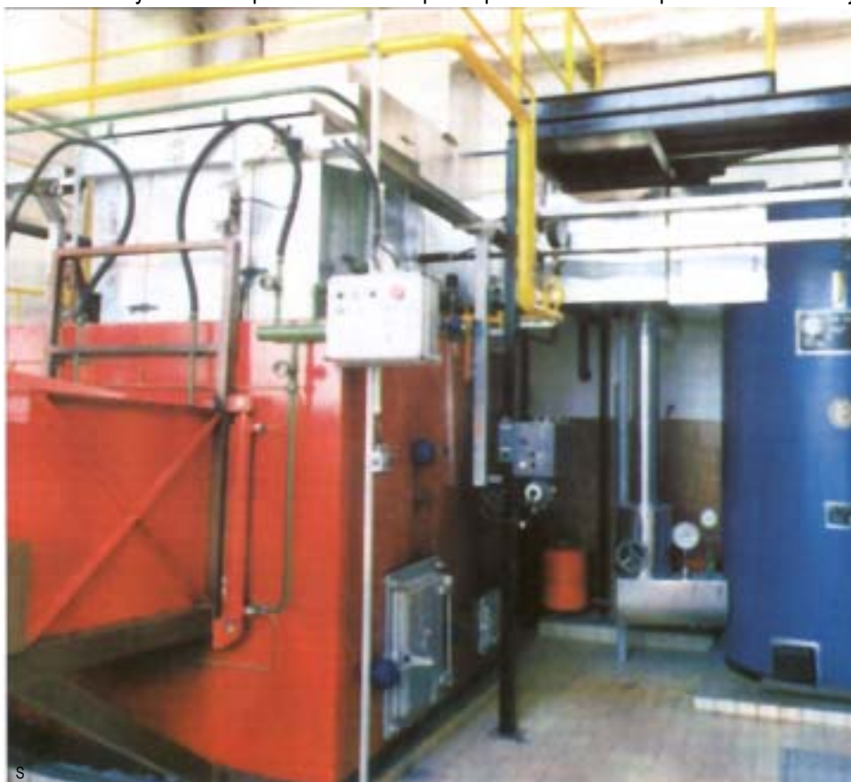
P – 80 detail spalovací pece a kotle
